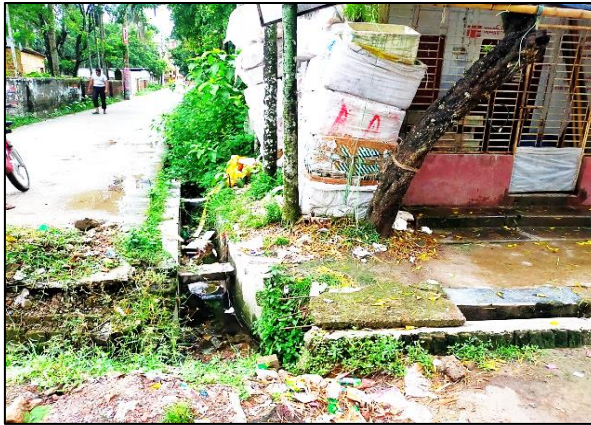
Drain -08, Kumarkhali Pourashava
